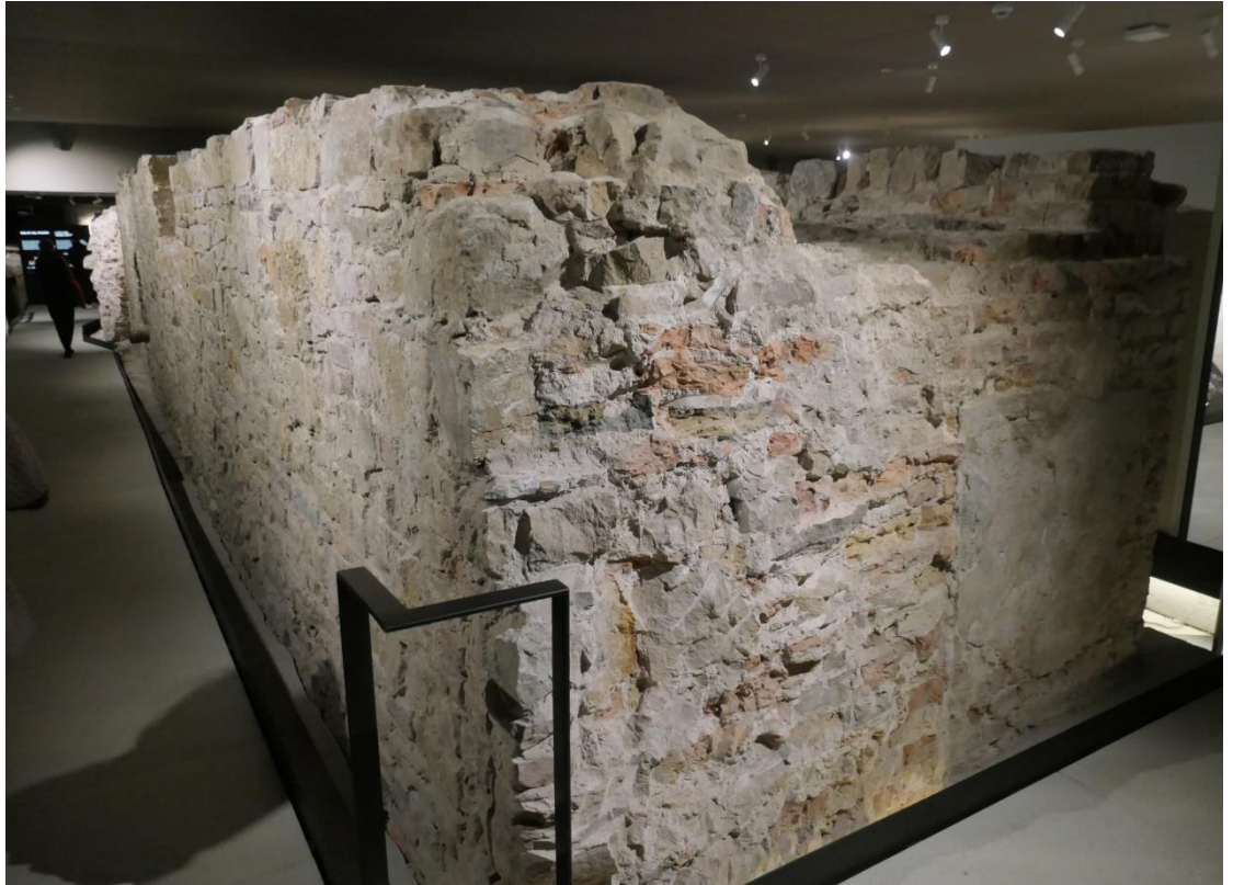
Hofmauern vom ehem. Berliner Stadtschloss im Humboldtforum (2021)
