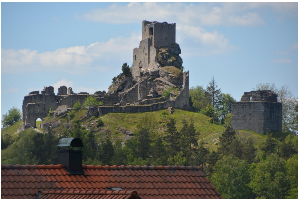
Burgruine Flossenbürg vom Eingangsbereich des ehem. KZ-Geländes aus gesehen (Foto Großmann, 2020)
