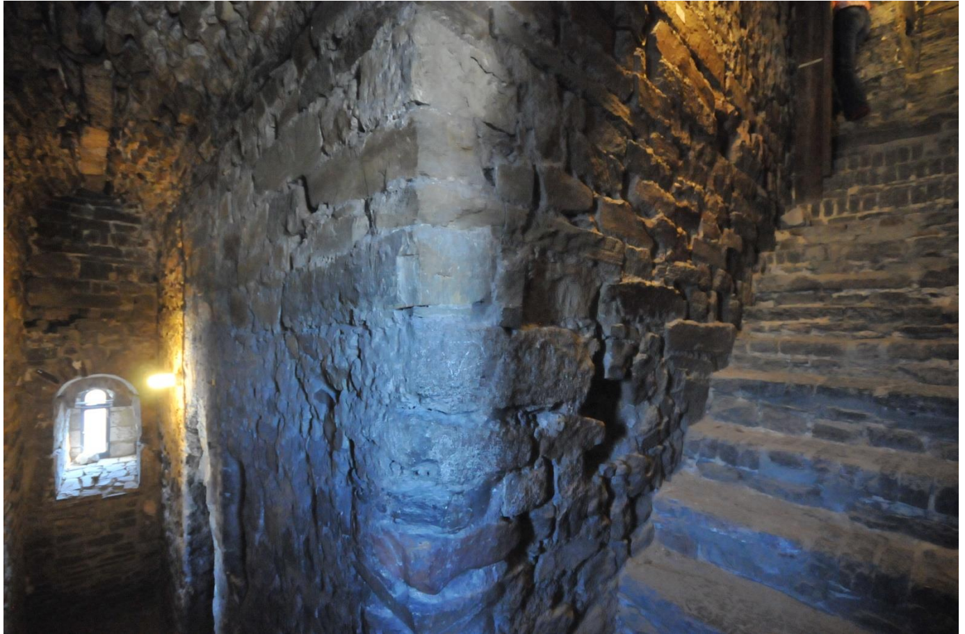
Es geht bergauf – Karolingische Treppe im Granusturm der Kaiserpfalz Aachen (Foto: Großmann 2012)
