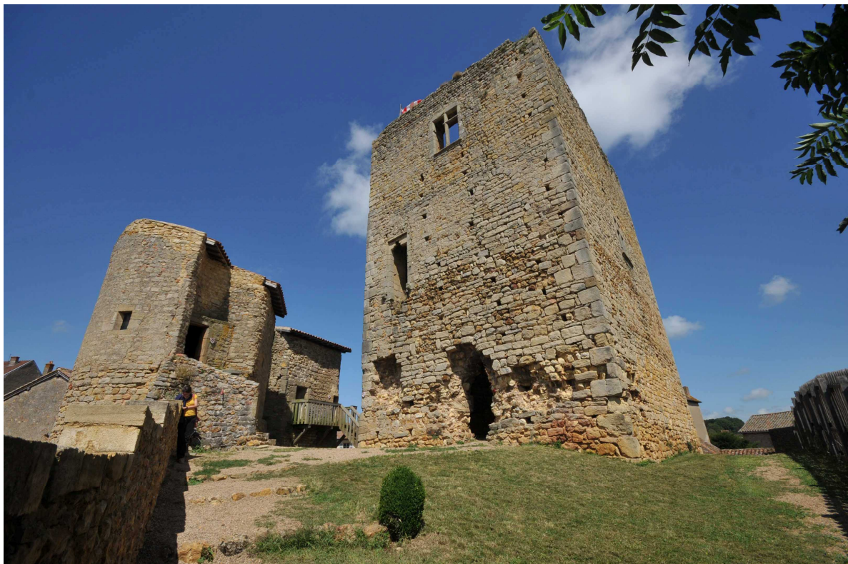
Semur, Gesamtansicht der Innenburg von Süden Seite 12 Bild links Innenansicht nach Westen und Bild rechts Aufmaß von J. Vallet (2004)
