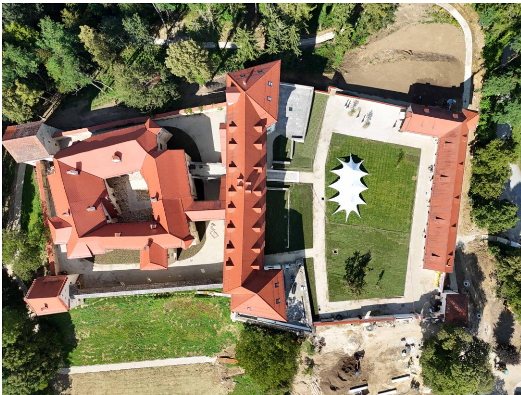
Negova, Kernburg links, vorgelagerter Renaissanceriegel in der Mitte, Vorburg rechts. Norden ist links oben (Foto UG, 2026)
