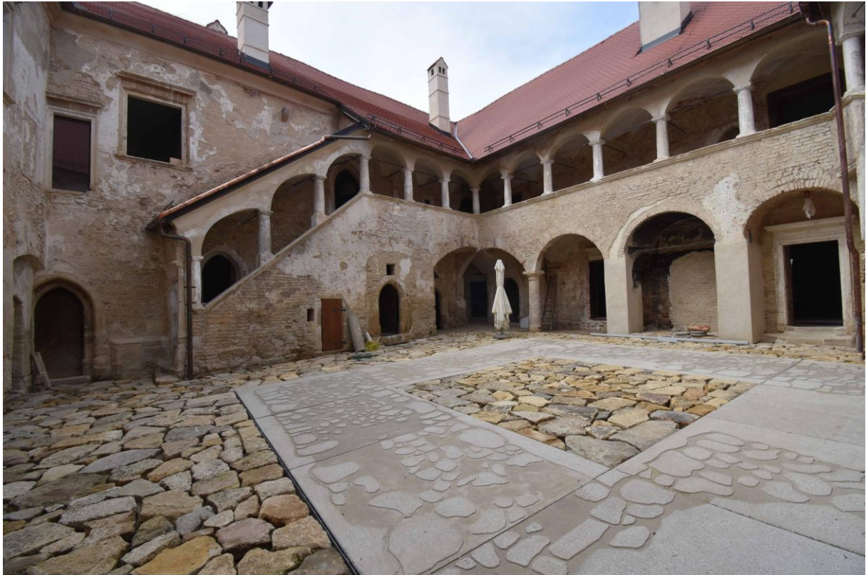
Nögeva, Innenhof mit Andeutung des Bergfrieds, links Tür zur Kapelle, hinter der 1. Treppenarkade Tür zur Empore. (2026)
