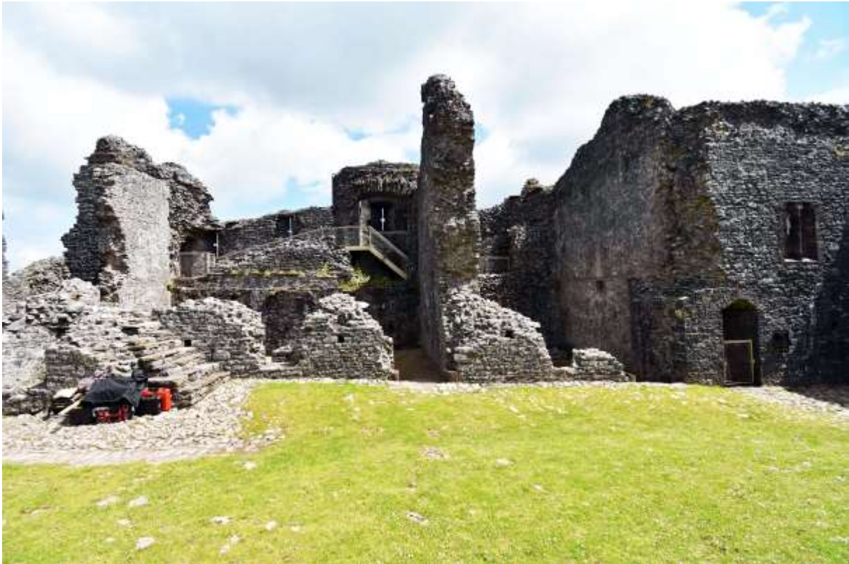
Carreg Cennen. Wohnflügel, rechts verkleinerter Wohnbau, nach links anschließend abgeteilter Raum unbekannter Funktion, links Halle im OG, vorn links Treppe zur Halle
