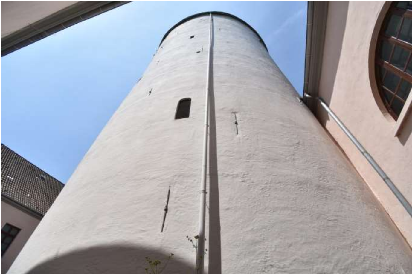
Jever, Bergfried, als Schlossturm in den weitgehend renaissance- und barockzeitlichen Bau integriert (UG, 2023)
