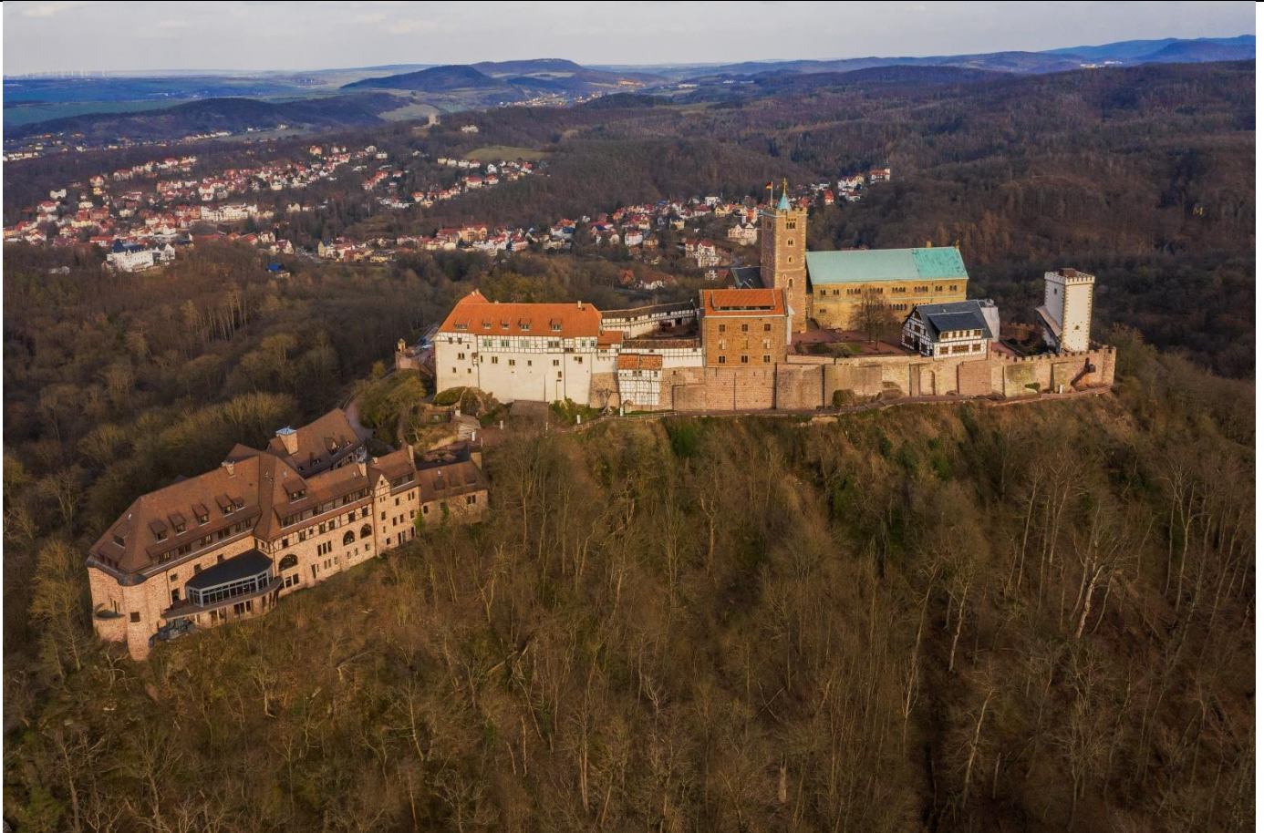
Wartburg, Luftbild von Westen (Björn Chilian, Deutsches Burgenmuseum, 2021) Vorne links das Wartburg-Hotel von Bodo Ehardt, in der Kernburg links die von Ehardt umgebaute Vogtei
