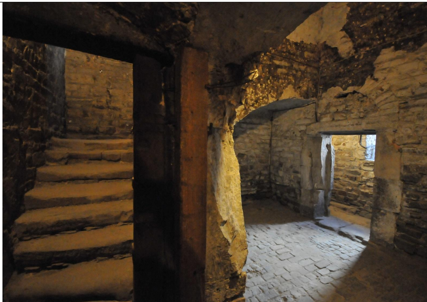
Aachen, Karolingisches Treppenhaus am Rathaus. Wechselnder Treppenlauf um einen Innenraum (Foto: UG, vgl. Rundbrief 74)
