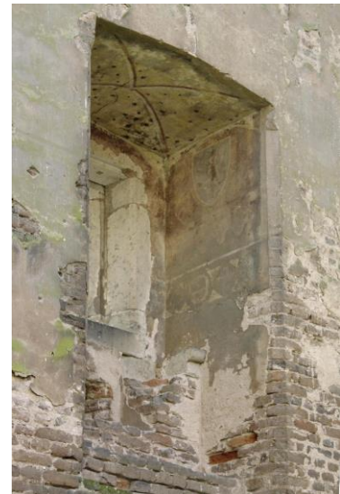
Abb. 3: Ein südliches Fenster im unteren Festsaal mit Sitznische und Malerei, Foto: Bartoli/Großmann, FH Köln 2008.
