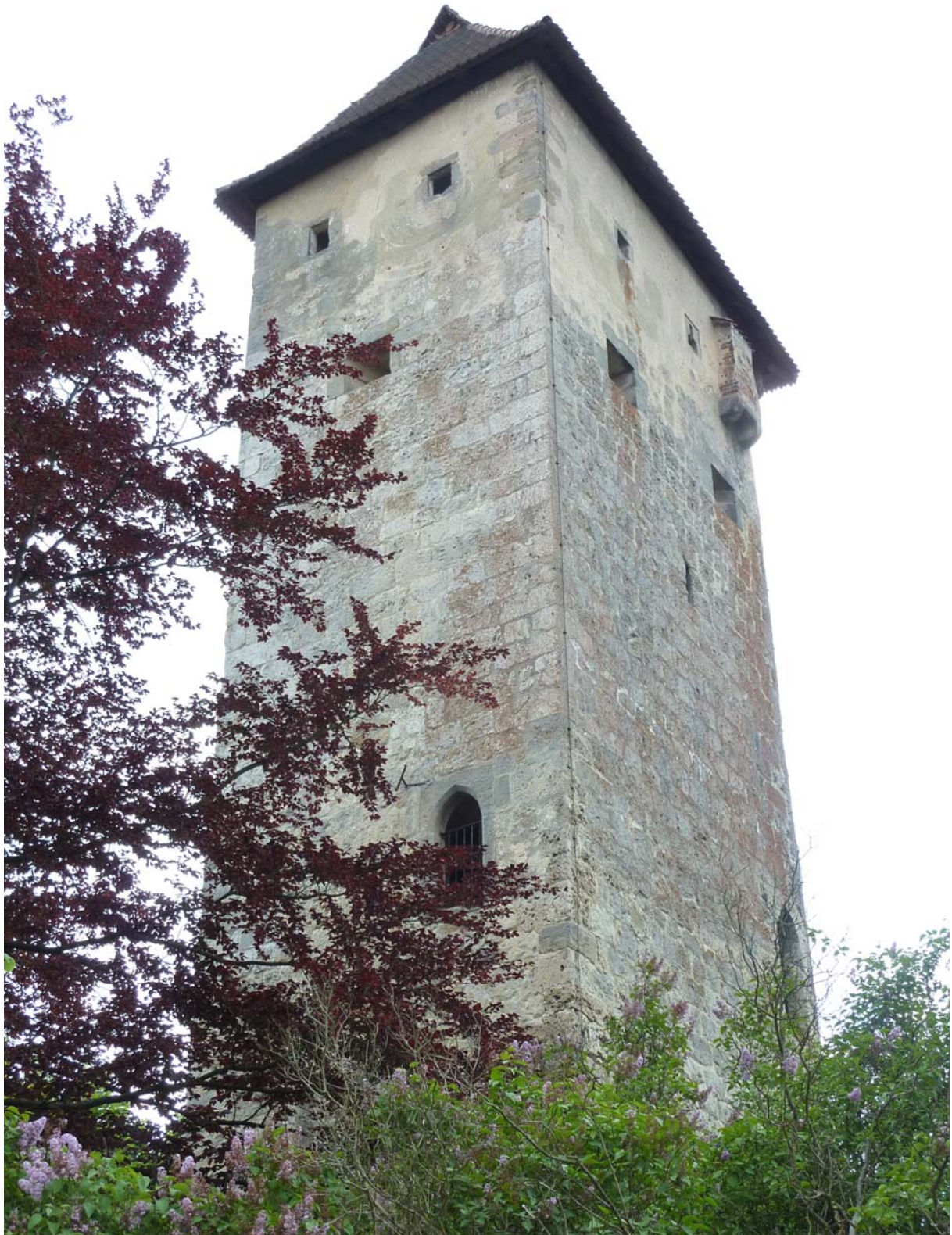
Veldenstein, Bergfried, mit ursprünglichem Eingang (links) und Abort (rechts) sowie aufgestockter neuerer Türmerwohnung
